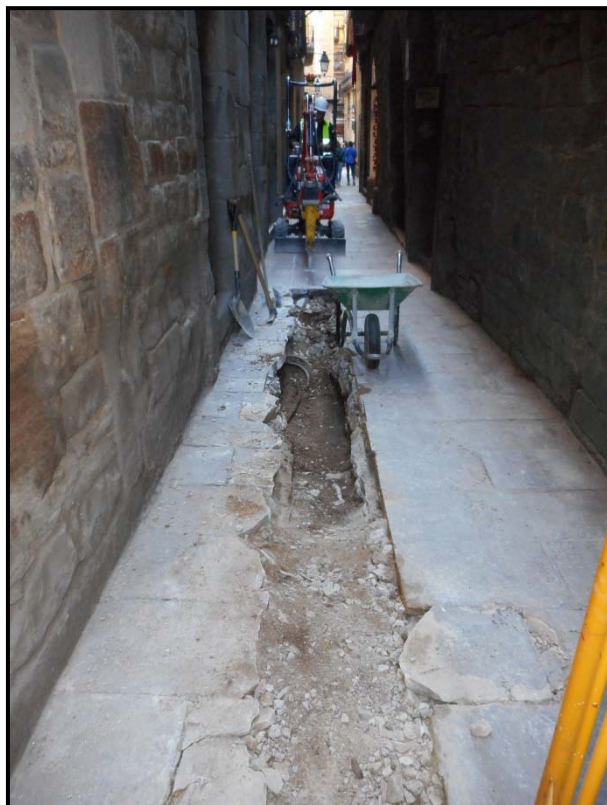
17. Treballs de buidat de la rasa al carrer de Sant Domènec del Call.
