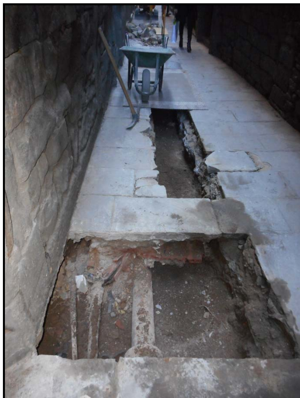
20. Treballs de buidat de la rasa al carrer de Sant Domènec del Call.
