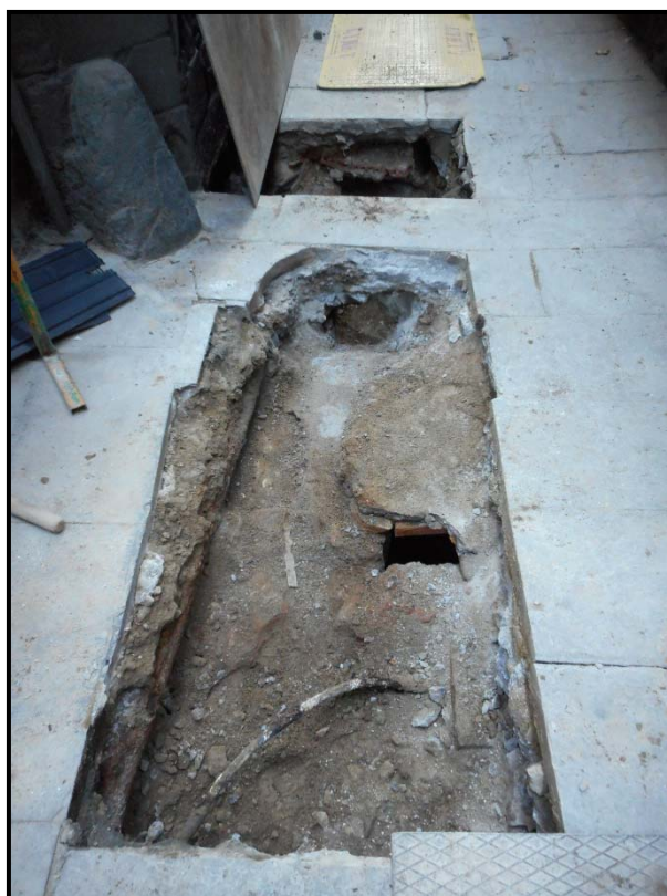
22. Serveis i embornals actuals localitzats durant les tasques de realització de la rasa al creuament del carrer Marlet amb el carrer de Sant Domènec del Call.
