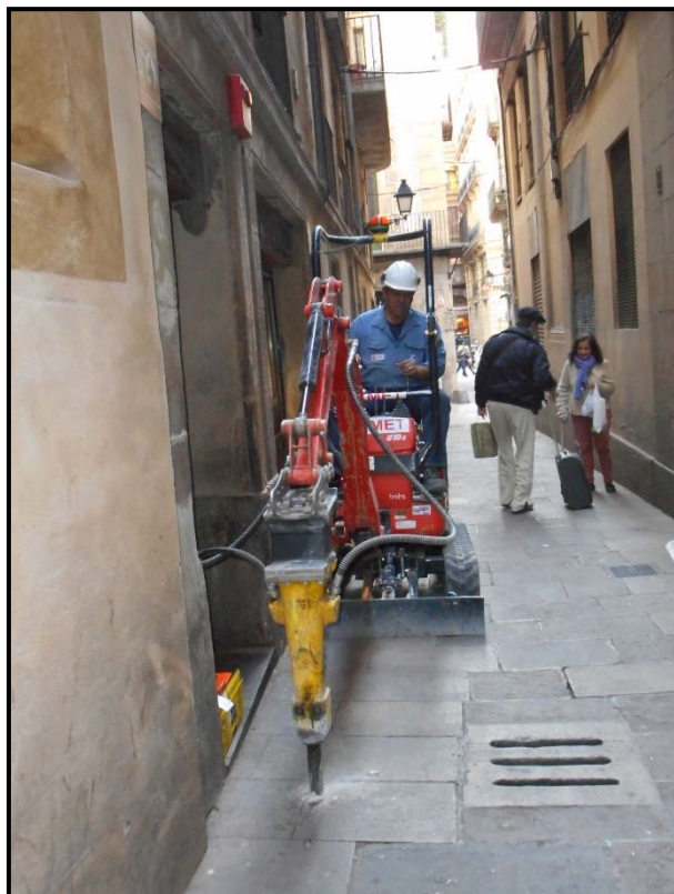
13. Inici dels treballs de la rasa al carrer de Sant Domènec del Call.
