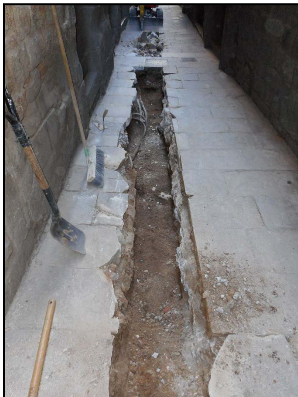
18. Treballs de buidat de la rasa al carrer de Sant Domènec del Call.
