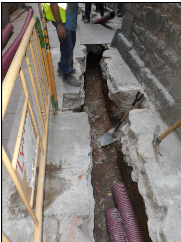
10. Rasa davant el núm. 5 del carrer Marlet. Instal·lació de tubs.
