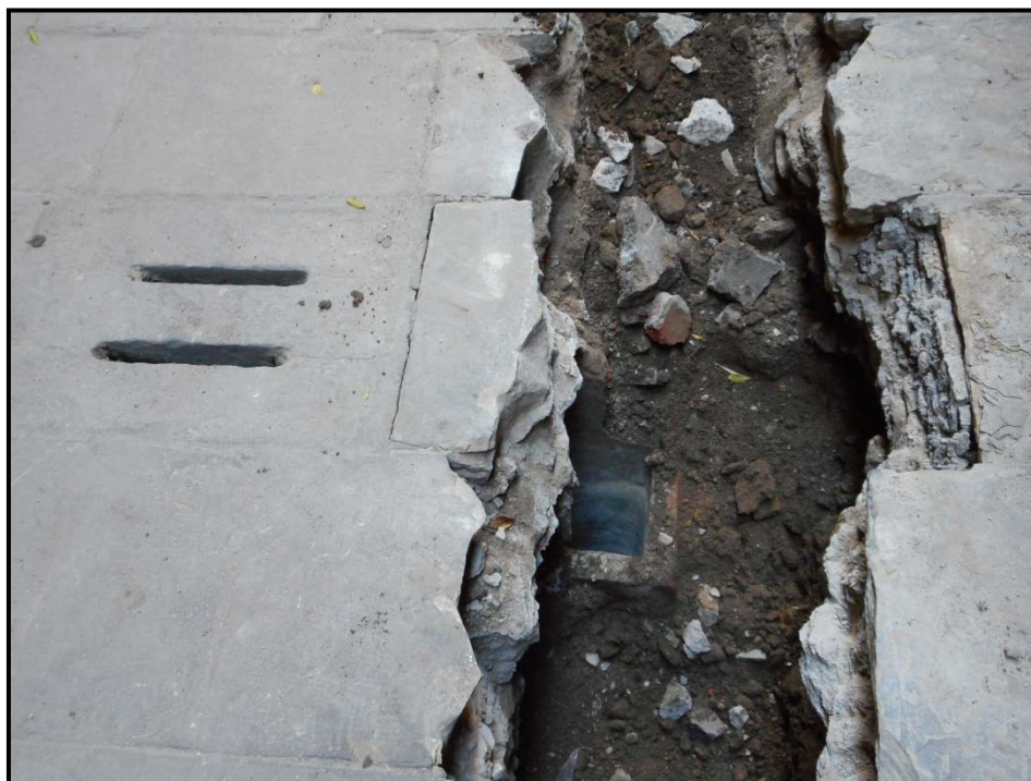
6. Serveis i embornals actuals localitzats durant les tasques de realització de la rasa al carrer Marlet.
